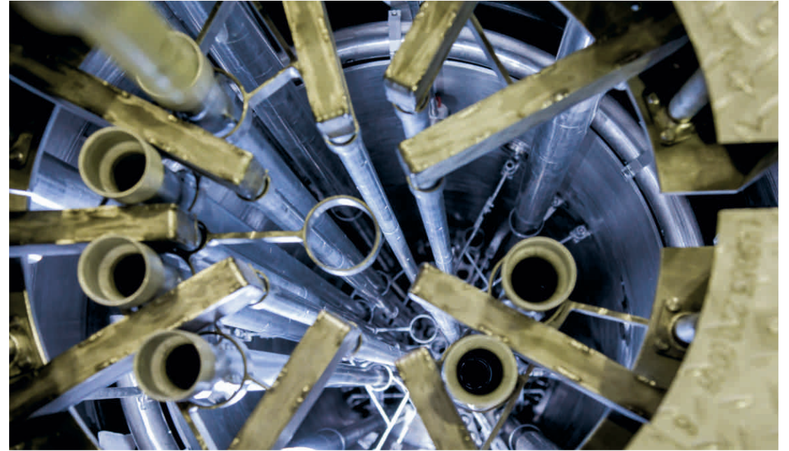
Реакторное внутрикорпусное оборудование
